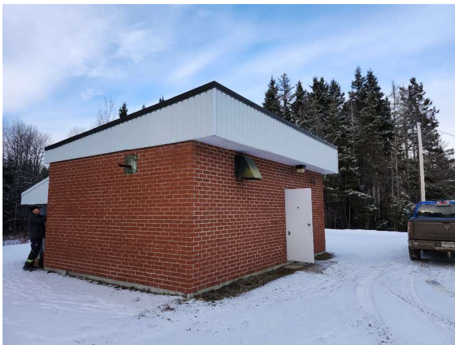
1. Vue de la station de pompage
