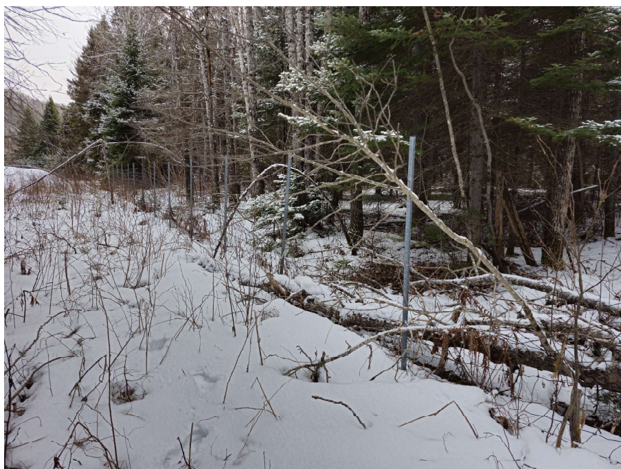
4. Vue de l'état de la clôture autour du site de pompage
